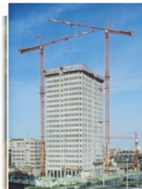
• Orientation de grues et Levage
